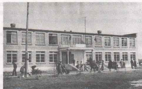
Здание строящейся школы, 1974 г.
