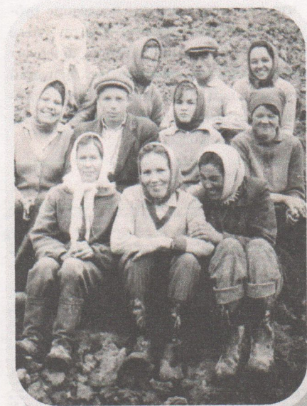
102 км, укрепление откосов вдоль железнодорожного полотна, 1964 год. Первый ряд (справа-налево) Матвеева А., Трошкина В., Некрасова Л.
